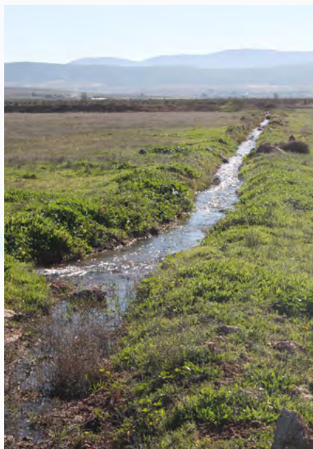
Figura 1. El cauce de abono, establecido en 1817 era un canal directamente excavado en la tierra. En febrero de 1825 el ayuntamiento solicitó a la Real Empresa de San Isidro su argamasado para garantizar el caudal. Foto: Autores.
