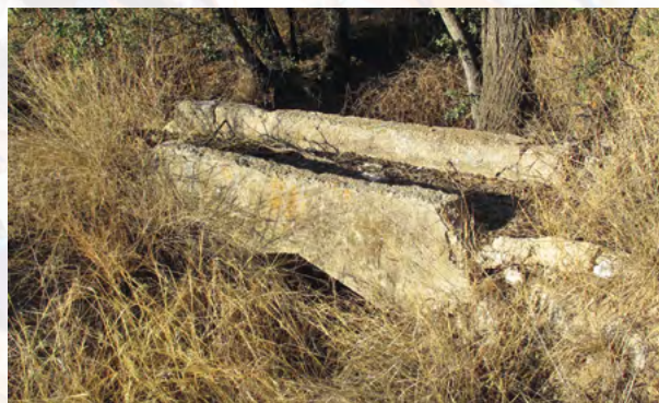
Figura 9. Acueducto del Brazal de las Carrascas sobre el cauce de San Isidro, hoy desaparecido. Foto: Autores (2016).
